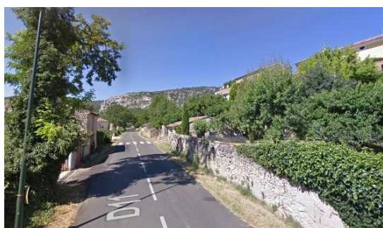
5. Croisement RD 11 / montée piétonne vers la rue du Collet
