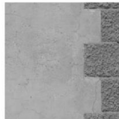
Décor de chaîne latérale harpée enduite à la tyrolienne à finition grenue formant un fort contraste de teinte et de texture (Montagnac-Montipezat)
