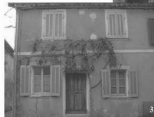
1. Enduit jeté et recoupé à pierres vues (La-Palud-sur-Verdon) 2. Enduit jeté au balai (Valensole) 3. Enduit à la tyrolienne au mortier à gros grain teinté à l'oxyde métallique (Aillons)
