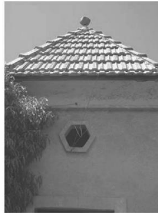
Tuiles plates mécaniques (cabanon à Riez)
