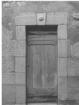
Soubassement et encadrement de porte en pierre calcaire froide taillée (La Garde)
