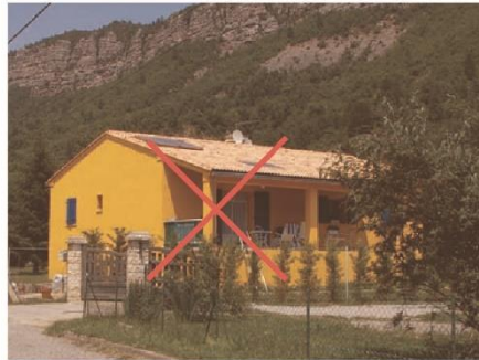
Enduit de teinte trop soutenue (à proscrire)
