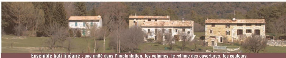
Ensemble bâti linéaire : une unité dans l'implantation, les volumes, le rythme des ouvertures, les couleurs
